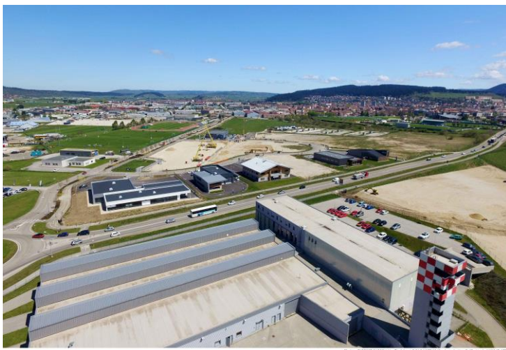
Figure 8: photographie zone des Gravilliers, Pontarlier. Source : Ville de Pontarlier
